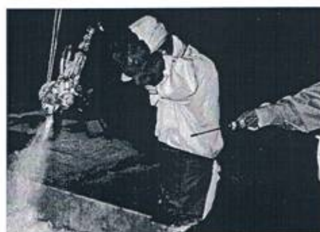
図 5: グラスファイバー樹脂吹き付け作業、有機ガスマーターによる瞬間値の計測
